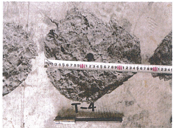
写真-5 破壊状況 試験体記号：T-4 最大荷重：24.0kN A：コーン状破壊
