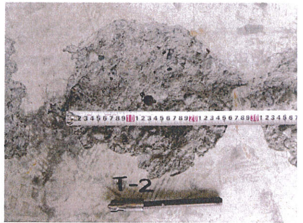
写真-3 破壊状況 試験体記号：T-2 最大荷重：25.8kN A：コーン状破壊
