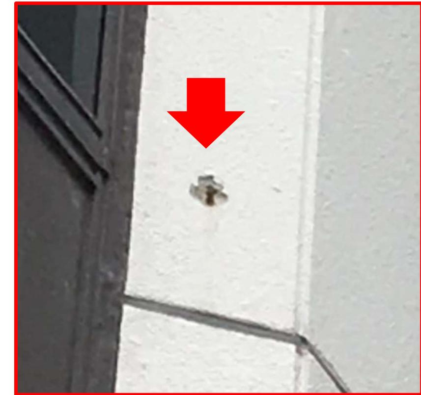
画像では、アンカーが錆び、コンクリート表面が剥がれ落下してます。
